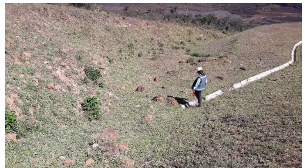
Foto 54 – Contato maciço/ombreira esquerda: região sem canaleta perimetral.
