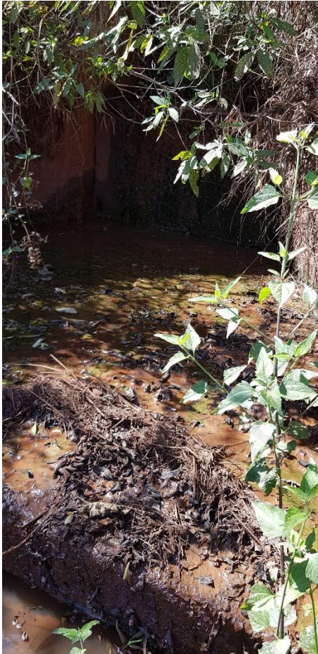
Foto 59 – Detalhe da saída do extravasor, com erosão abaixo da laje.
