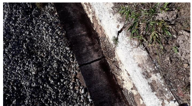
Foto 48 – Trinca em canaleta na ombreira esquerda.
