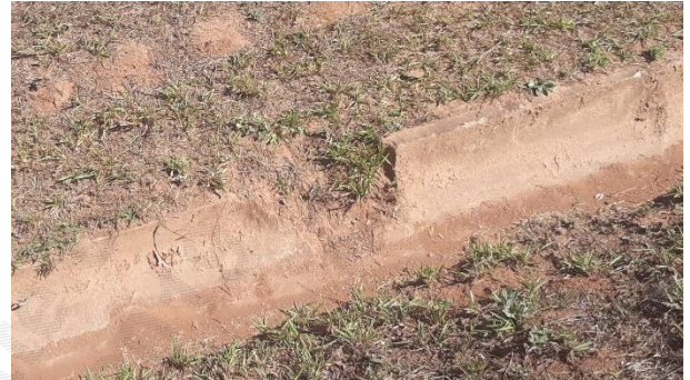
Foto 50 – Canaleta quebrada por pisoteamento de animais.
