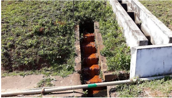
Foto 31 – Saída de drenagem interna com colóide.
