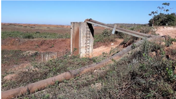
Foto 7 – Tubulação direcionando a água bombeada para o extravasor operacional.
