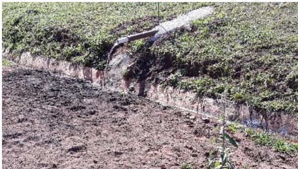
Foto 33 – Um dos novos DHPs instalados na El. 899,00 m.
