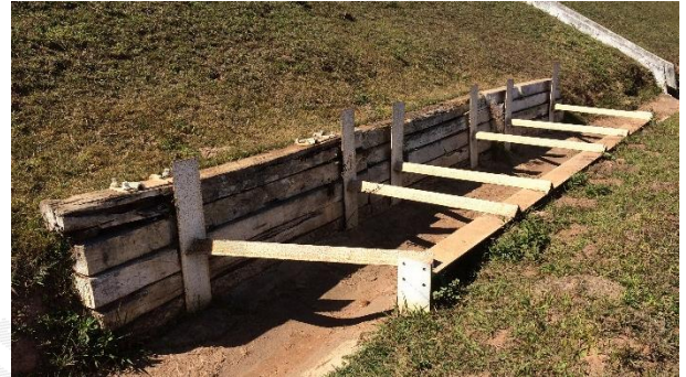
Foto 20 – Estrutura de contenção da ruptura localizada.
