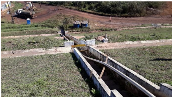
Foto 51 – Início dos trabalhos de reparo em descida hidráulica.
