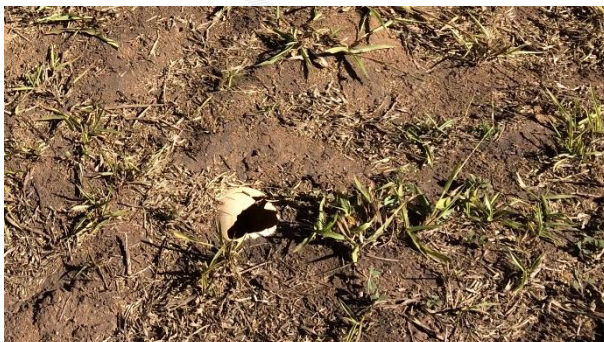
Foto 29 – Tubo para saída da drenagem interna, exposto e danificado.
