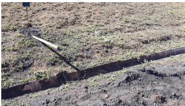
Foto 35 – Novo DHP na El. 916 m ( próx. à ombreira direita), com canaleta assoreada.
