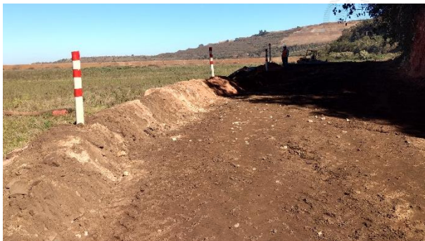
Foto 3 – Acesso ao fundo do reservatório, pela ombreira direita.
