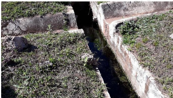
Foto 45 – Assoreamento de canal de drenagem.
