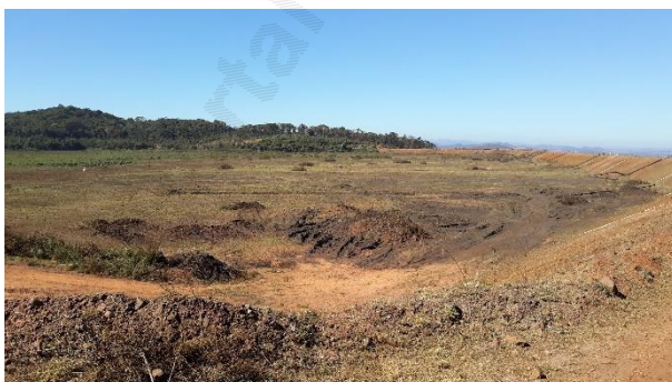
Foto 5 – Limpeza do reservatório em progresso.
