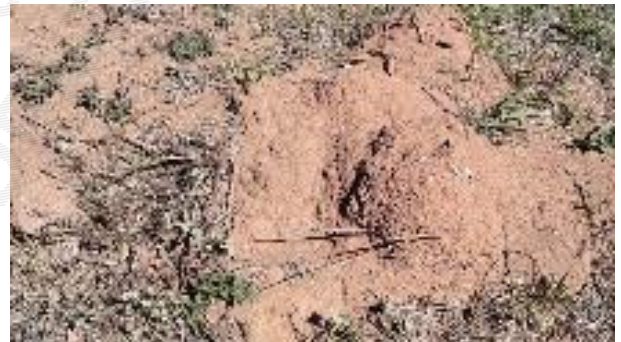
Foto 22 – Cupinzeiro no talude de montante após tratamento com pesticida.
