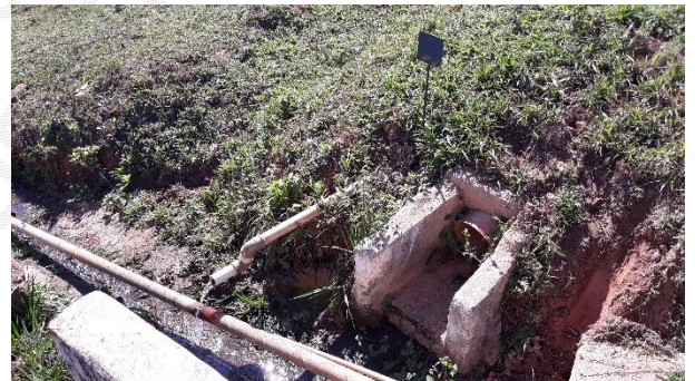
Foto 34 – Novo DHP na El. 885 m ( próx. à ombreira esquerda).
