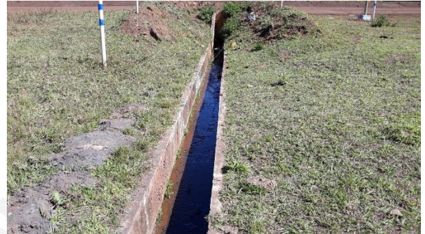
Foto 44 – Assoreamento de canal de drenagem.
