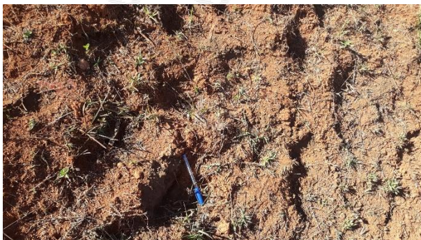
Foto 17 – Detalhe da Foto 16: sulcos no talude de jusante.
