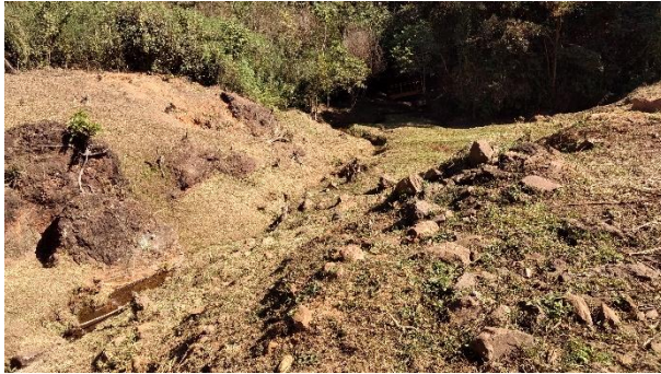
Foto 25 – Região a jusante da barragem, com vista para jusante.
