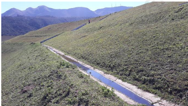
Foto 39 – Água empoçada em canaleta.
