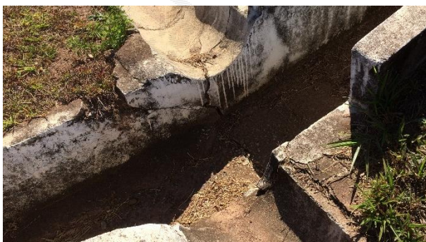
Foto 47 – Dano estrutural no encontro de canaleta com descida hidráulica.
