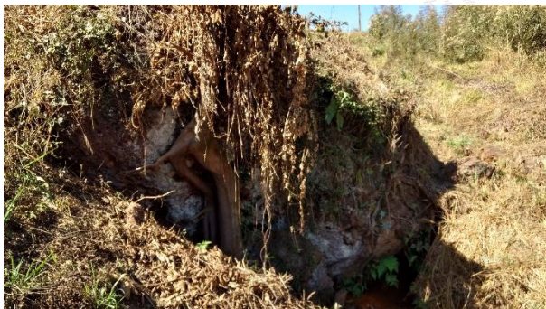
Foto 27 – Detalhe da Foto 26, bloco sob a estrada de acesso.
