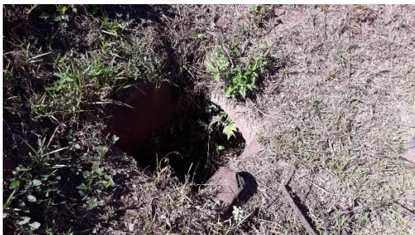
Foto 53 – Poço e tubulação em concreto na ombreira esquerda.
