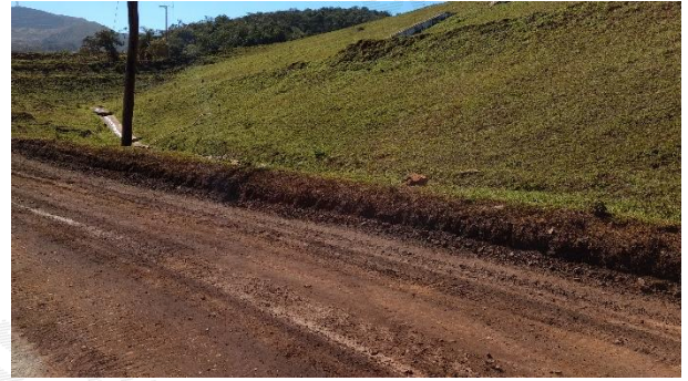
Foto 2 – Estrada de acesso, ombreira esquerda.
