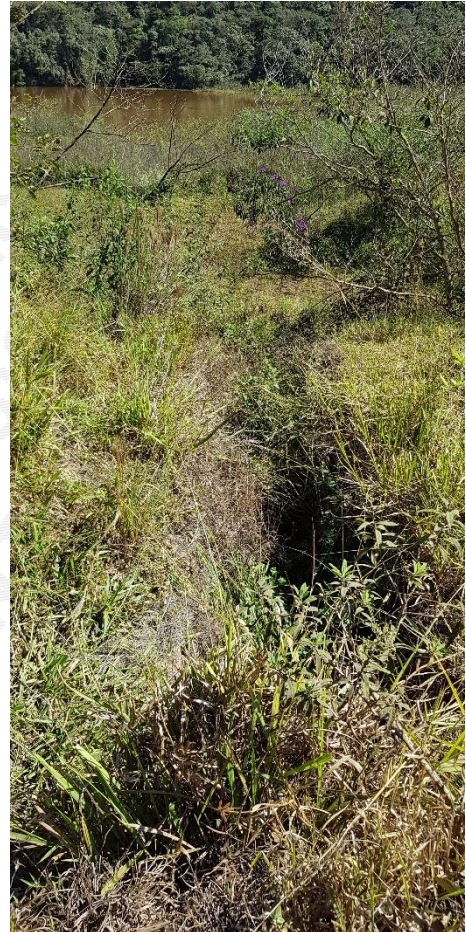
Foto 60 – Bacia de dissipação, no reservatório da Barragem VI.
