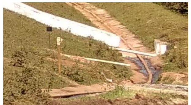
Foto 36 – Novo DHP no pé da barragem ( próx. à ombreira direita).
