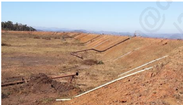
Foto 15 – Talude de montante.
