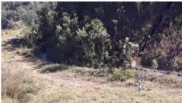
Foto 57 – Antigo canal extravasor na ombreira direita, necessitando limpeza.
