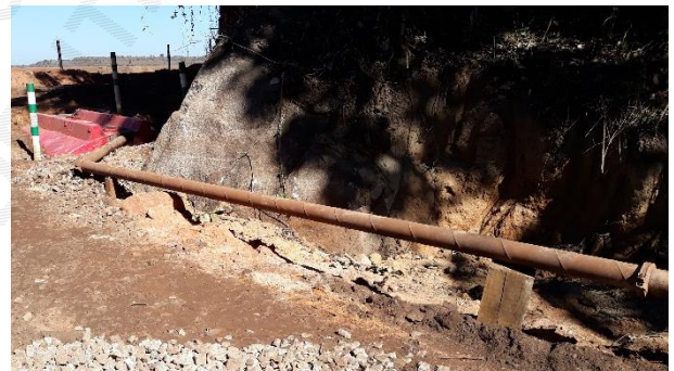
Foto 10 – Tubulação direcionando a água para o reservatório metálico.
