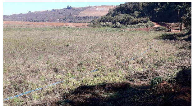
Foto 12 – Tubulação direcionando por gravidade a água para o sistema extravasor.
