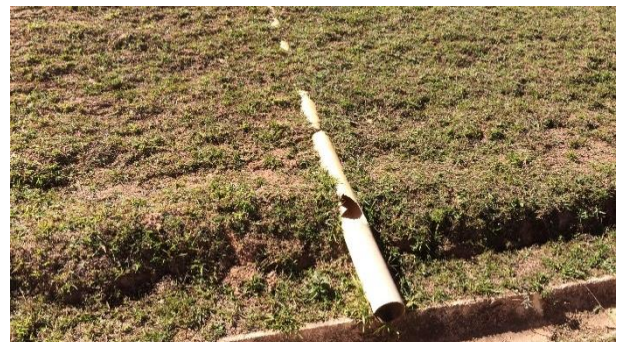
Foto 30 – Tubo para saída da drenagem interna, exposto e danificado.
