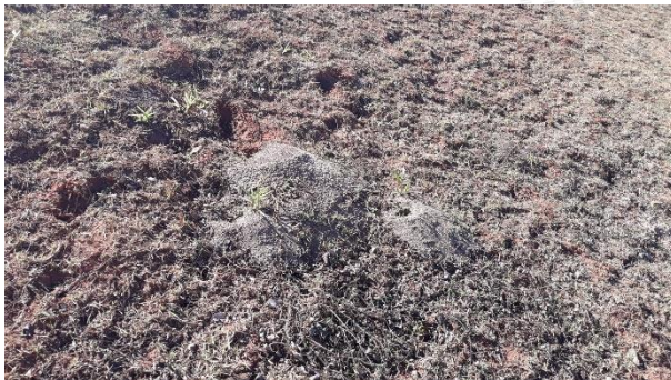
Foto 21 – Formigueiro no talude de jusante.
