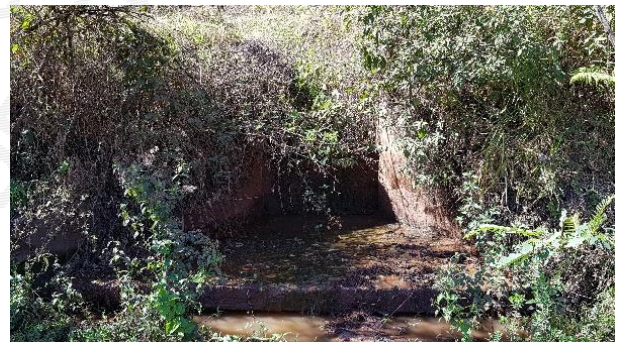
Foto 58 – Saída do sistema extravasor.
