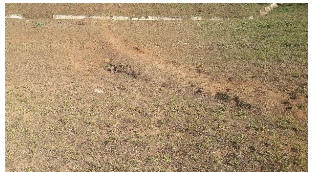
Foto 18 – Erosão superficial próxima à ombreira direita.
