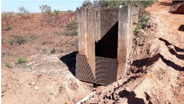
Foto 55 – Extravador operacional: torre de queda do 9º alteamento.
