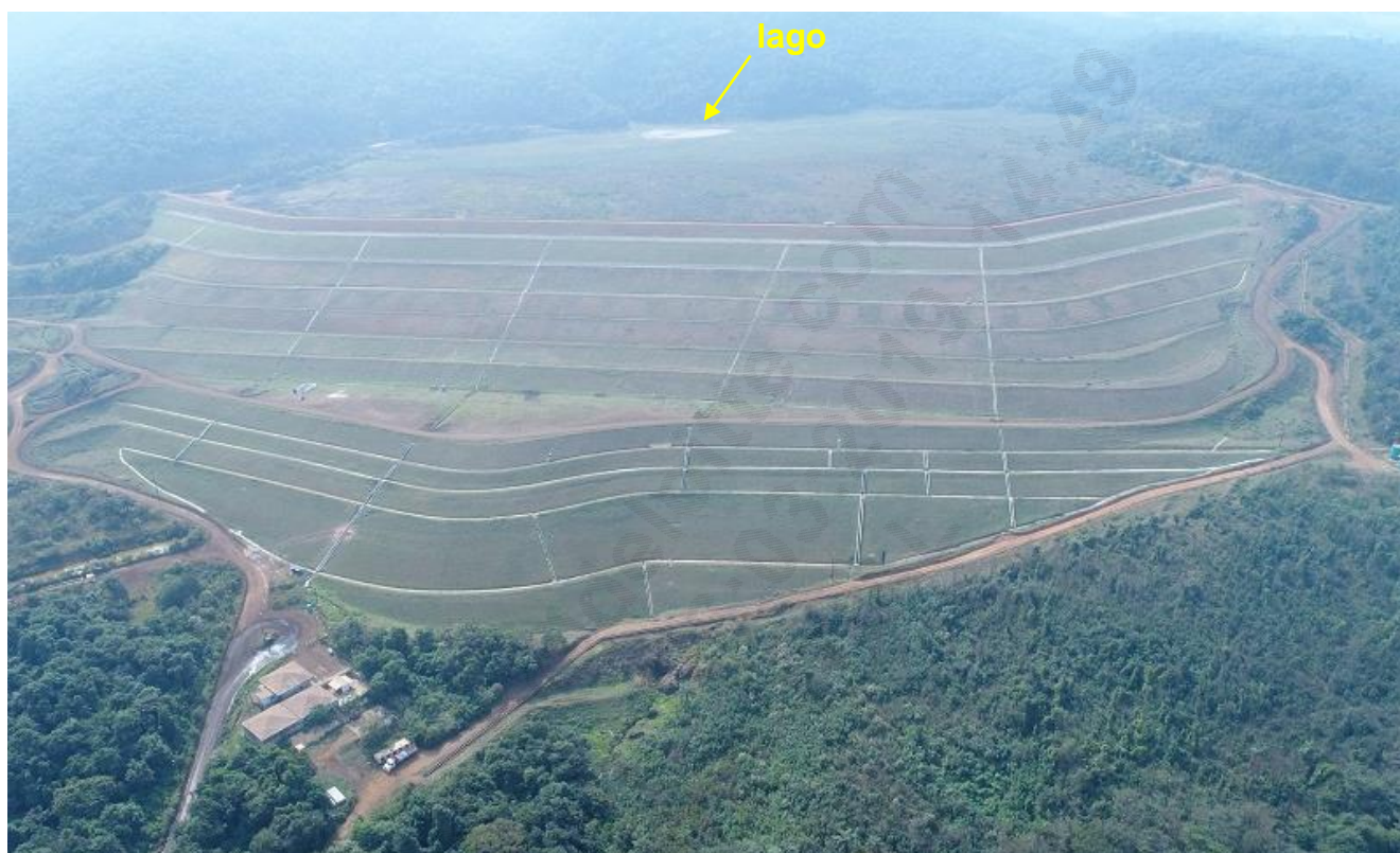
Figura 4.2 – Vista aérea da Barragem I. Fonte: (VALE, 2018).
