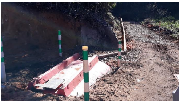
Foto 11 – Reservatório metálico parcialmente enterrado.
