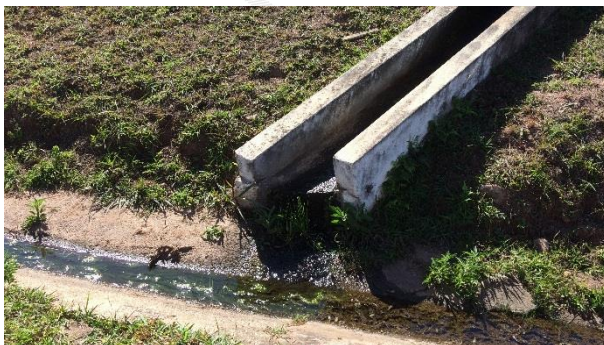
Foto 41 – Assoreamento e empoçamento em canaleta.
