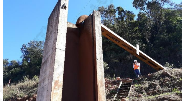
Foto 56 – Extravador operacional: torre de queda do 10º alteamento.
