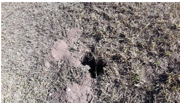
Foto 23 – Cupinzeiro removido no talude de jusante.
