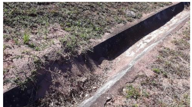
Foto 42 – Assoreamento de canaleta de drenagem por erosão superficial.
