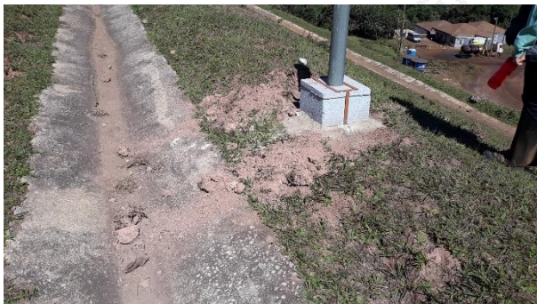
Foto 63 – Resíduos de obra assoreando a drenagem superficial.
