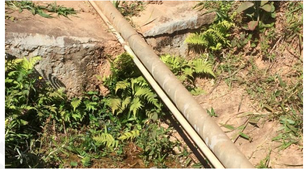
Foto 32 – Saída de drenagem interna entupida com vegetação.
