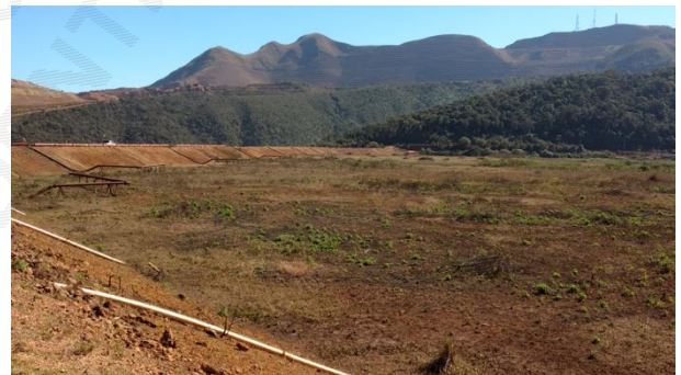
Foto 4 – Reservatório da Barragem I.
