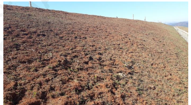
Foto 16 – Falha no revestimento vegetal no talude de jusante.
