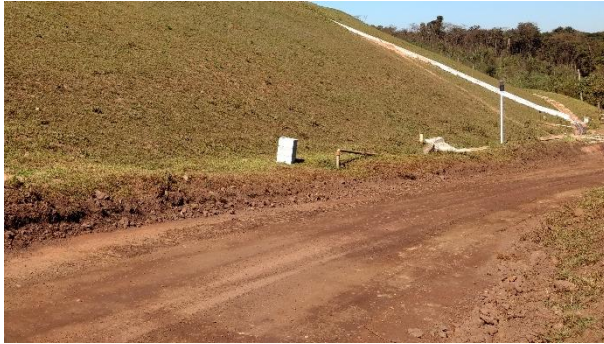
Foto 1 – Estrada de acesso, ombreira direita.
