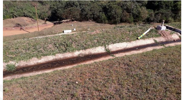
Foto 38 – Água empoçada em canaleta.
