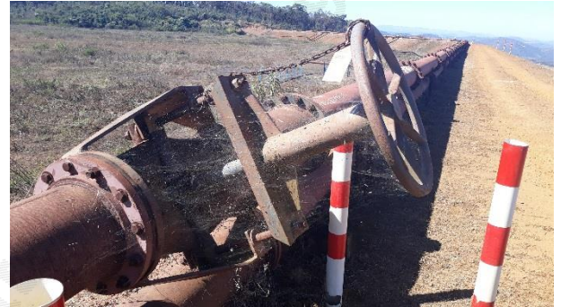
Foto 14 – Rejeitoduto na crista, inoperante.
