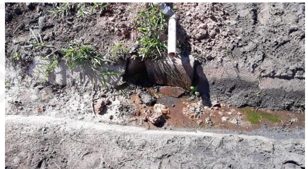
Foto 46 – Dano estrutural à canaleta durante instalação de DHP.
