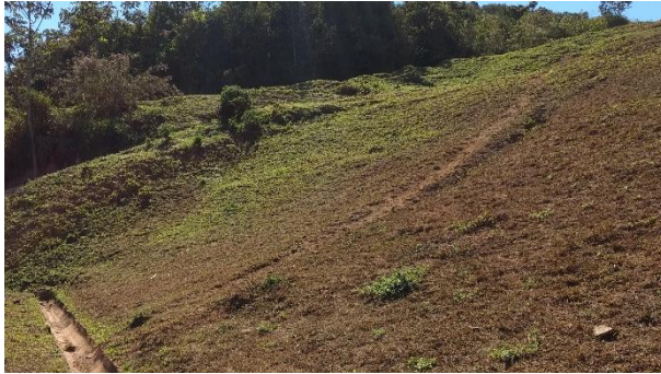
Foto 19 – Erosão superficial próxima à ombreira direita.
