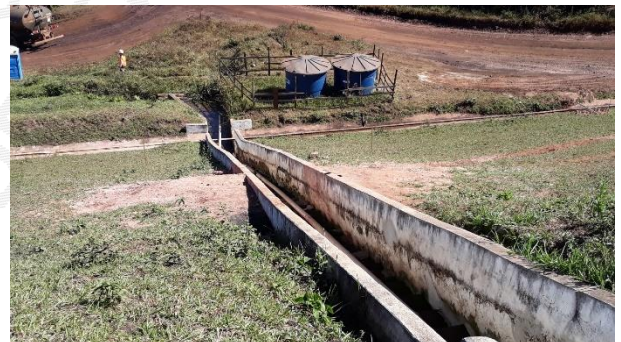
Foto 52 – Região onde ocorreu faturamento hidráulico.
