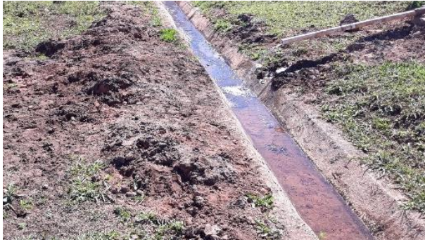
Foto 43 – Canaleta assoreada com material escavado para instalar DHP.
