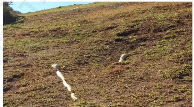
Foto 28 – Tubos para saída da drenagem interna, expostos na face do talude.
