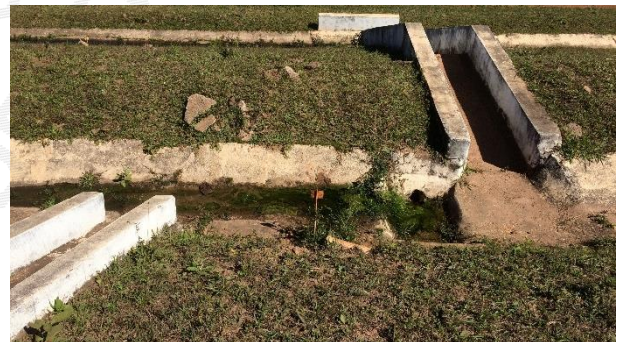
Foto 40 – Assoreamento e empoçamento em canaleta, tubo paralelo à descida hidráulica.
